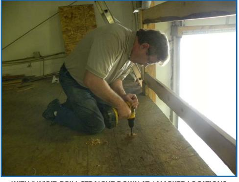
WITH 5/8" BIT: DRILL STRAIGHT-DOWN AT 4 MARKED LOCATIONS
